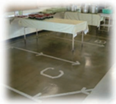
(Aチーム 定期清掃施工前：床は黒ずんでいる)
